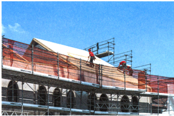
Die ovalen Öffnungen verhelfen dem Gemeindehaus schon im Rohbau zu Aufmerksamkeit.
